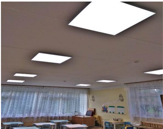
Изготовление и монтаж ФКУ ЛИУ-4 внутренних светодиодных светильников для нужд МКОУ «СКО Школа-Интернат №14 п. Надвоицы»
