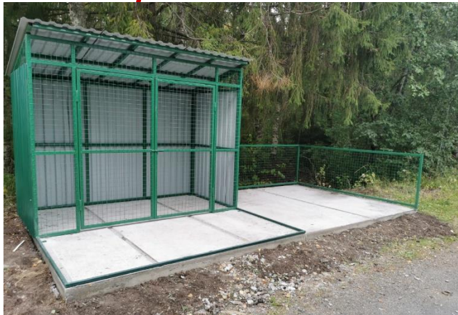
Изготовление и монтаж ФКУ ИК-9 контейнерных площадок под ТКО для нужд Администрации Питкярантского муниципального района
