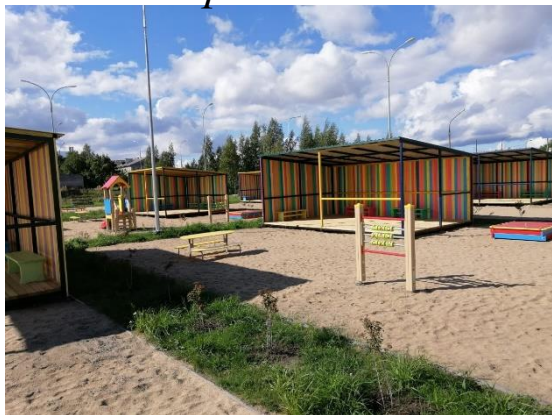
Изготовление и монтаж ФКУ ИК-9 теневого навеса для нужд МДОУ Детский Сад №9 «Теремок» с. Заозерье
